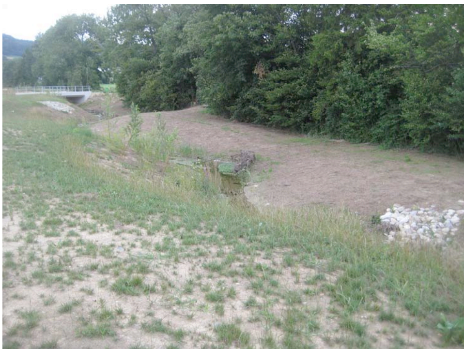
Nördlicher Abschnitt des renaturierten Harberenbaches mit Stein- und Totholzhaufen
